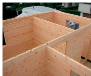
Assemblage à queue d'aronde pour madrier
