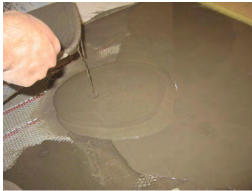
Egaline met glasvezel kan bijvoorbeeld dienen als basis om linoleum of tapijt op te leggen.
