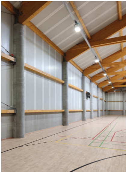
Colonnes de structure, Cendre
