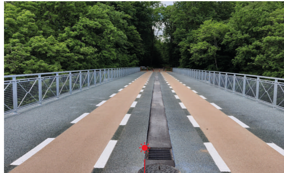
Piste cyclable en gravier luminescent au Viaduc de Conques
