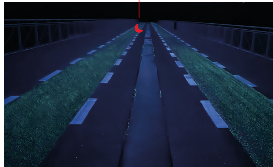
Piste cyclable en gravier luminescent au Viaduc de Conques
