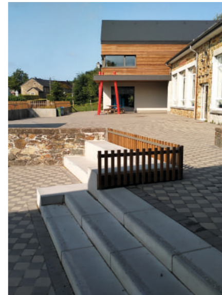
Marches avec bande bouchardée, Cendre
